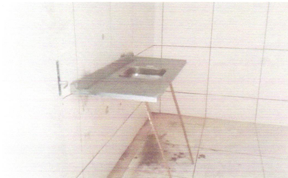
FOTO 06 - Pia de cozinha com bancada em aço inox, dim 1,20x0,60m c/ 01 cuba, válvula cromada, sifão cromado e torneira cromada, concretada e assentada. Rev.04
