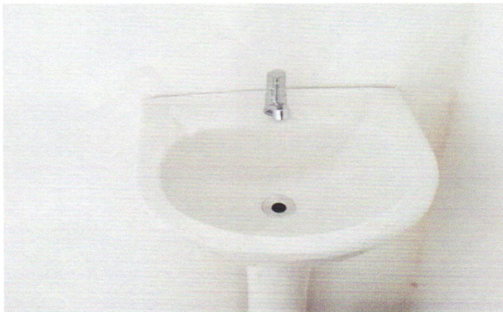
FOTO 05 – LAVATÓRIO LOUÇA BRANCA COM COLUNA, 44 X 35,5 CM, PADRÃO POPULAR, INCLUSO SIFÃO FLEXÍVEL EM PVC, VÁLVULA E ENGATE FLEXÍVEL 30CM EM PLÁSTICO E COM TORNEIRA CROMADA PADRÃO POPULAR - FORNECIMENTO E INSTALAÇÃO. AF_01/2020
