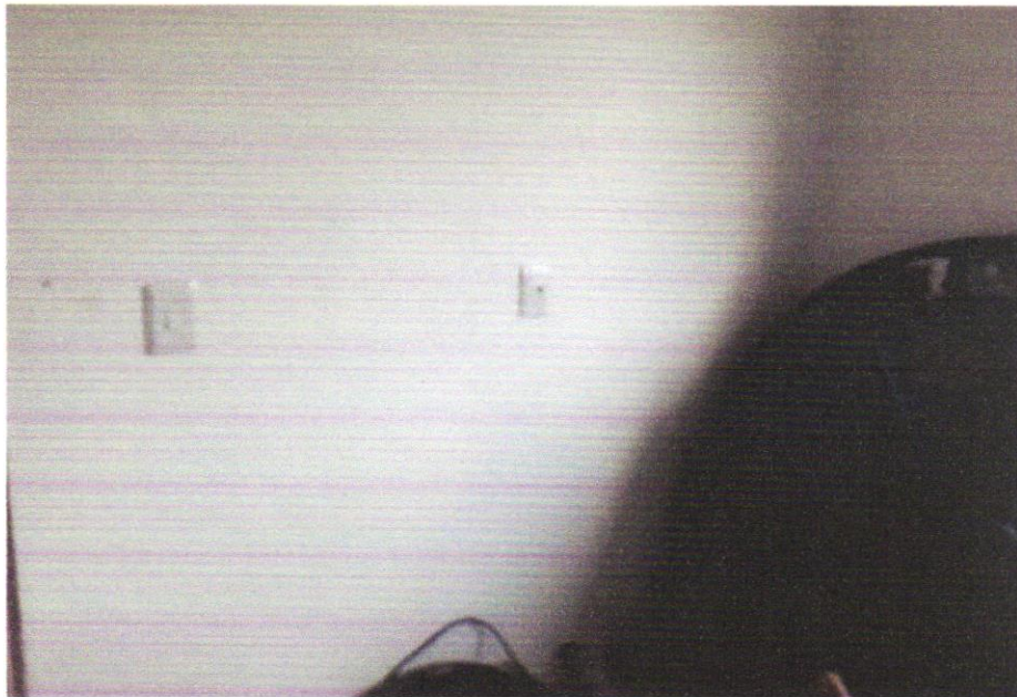
FOTO 04- INTERRUPTOR SIMPLES ( 1 MÓDULO) 10A/250V, INCLUINDO SUPORTE E PLACA FORNECIMENTO E INSTALAÇÃO. AF_12/2015.
